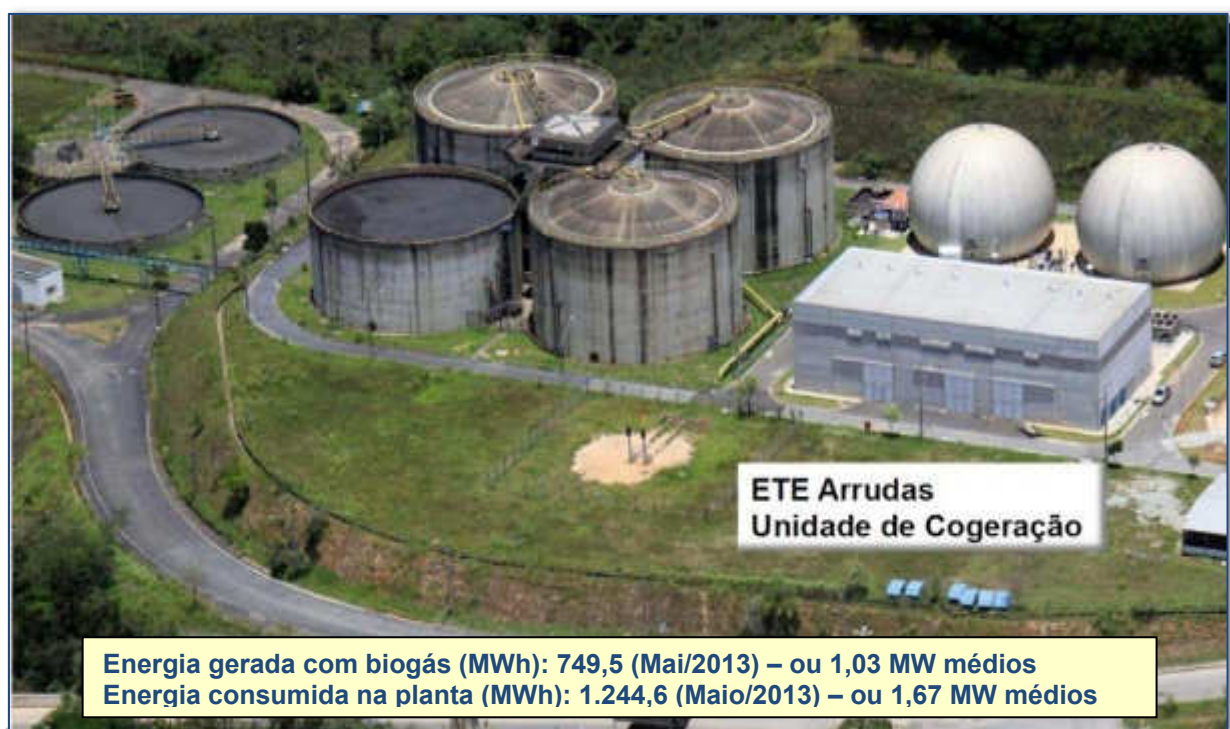
Figura 5.15 – ETE Arrudas/MG – Potência 2,4 MW. Fonte: Gaio (2013)
